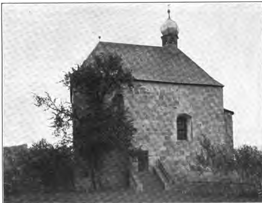
Fig. 121. Schönfeld. Südansicht der Kirche.
